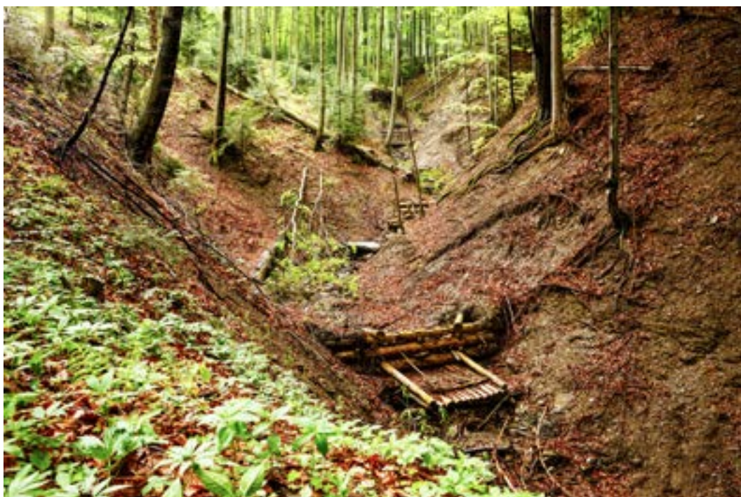
Fot. 149. Niewielkie zapory przeciwrumowiskowe rozłożone w wyerodowanym wąwozie na ciekіu okresowym, Nadleśnictwo Limanowa (archiwum CKPŚ)
