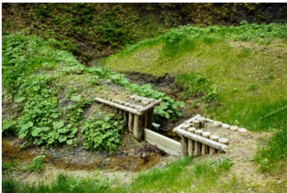
Fot. 31. Nawet małe zastawki wymagają wzmocnienia przyczółków w celu przeciwdziałania parciu wody (archiwum CKPŚ)
