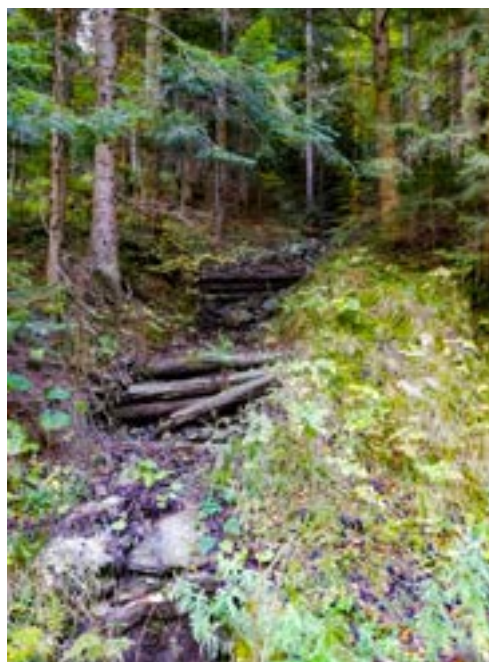
Fot. 102. Przegrody drewniane wypełnione gałęziówką i rumoszem skalnym (fot. Ł. Borek)
