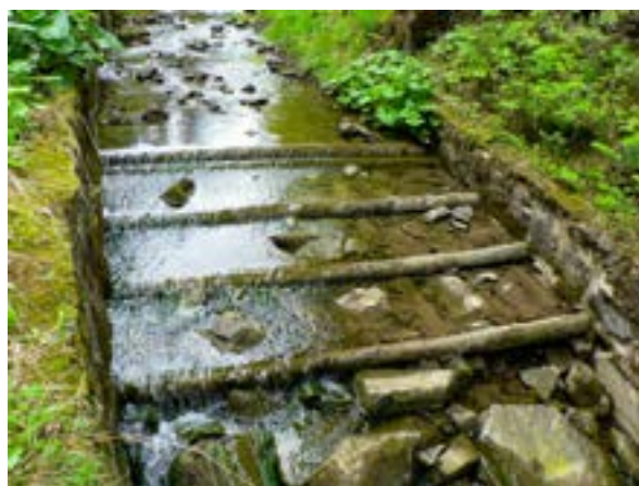
Fot. 129. Kaskada bardzo niskich progów, łatwa do pokonania dla organizmów wodnych, brak przelewów na małą wodę (fot. T. Kowalik)
