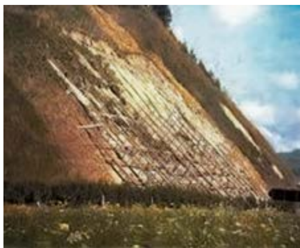
Fot. 65 i Rys. 69. Drewniane rusztowanie na skarpie wzmocnione nasadzeniami wierzbowymi [Begemann i Schiechl 1999]
