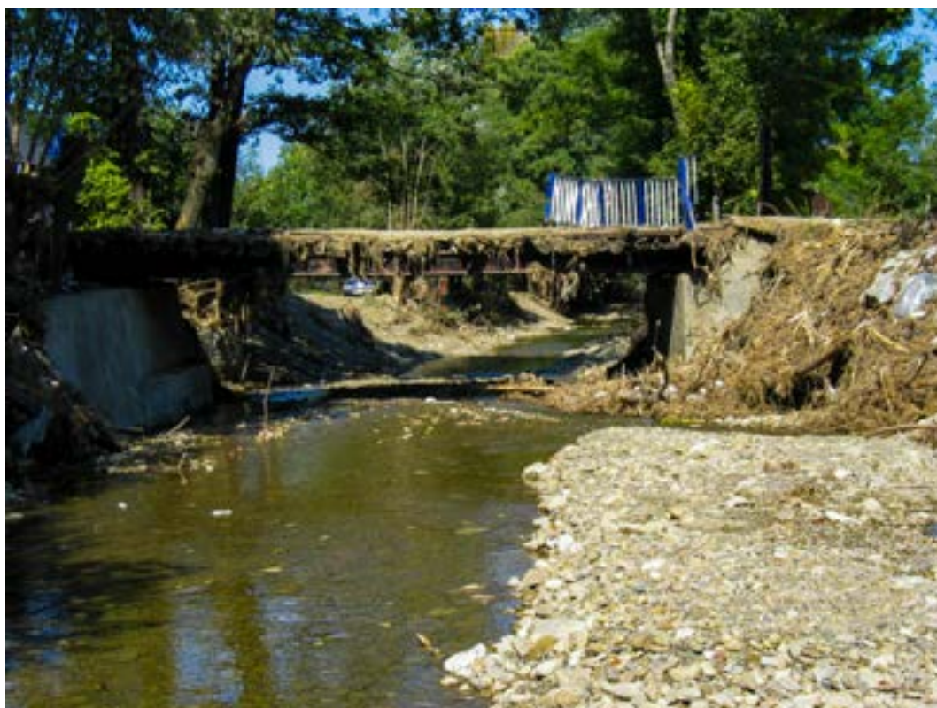
Fot. 145. Mostek z uszkodzoną barierką, ocalały po przejściu fali powodziowej, Targaniczanka (fot. L. Książek, 2005)
