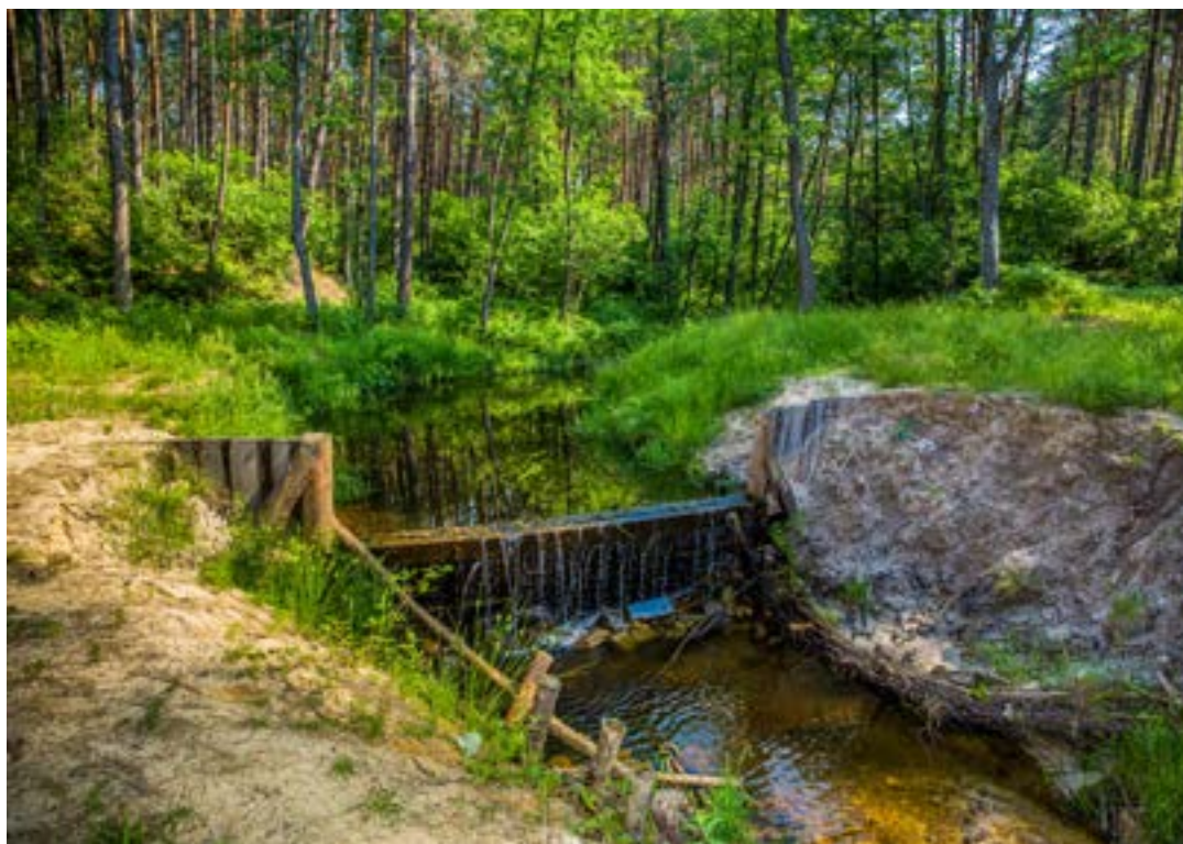
Fot. 36. Widoczna erozja dna i skarp prowadząca do osłabienia konstrukcji oraz wygięcia progu pod naporem wody, Nadleśnictwo Łagów (archiwum CKPŚ)
