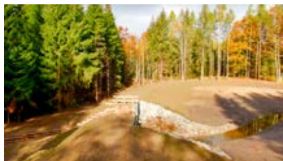
Fot. 26. i Fot. 27. Suchy zbiornik w Nadleśnictwie Śnieżka z przelewem szczelinowym [ https://www.youtube.com/watch?v=0KC01khUkeY ]
