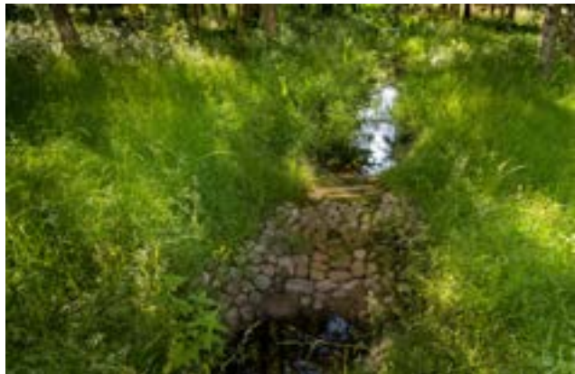
Fot. 49. Przetamowanie ziemno-kamienne z wykorzystaniem ścianki szczelnej w Nadleśnictwie Szczytno (archiwum CKPŚ)
