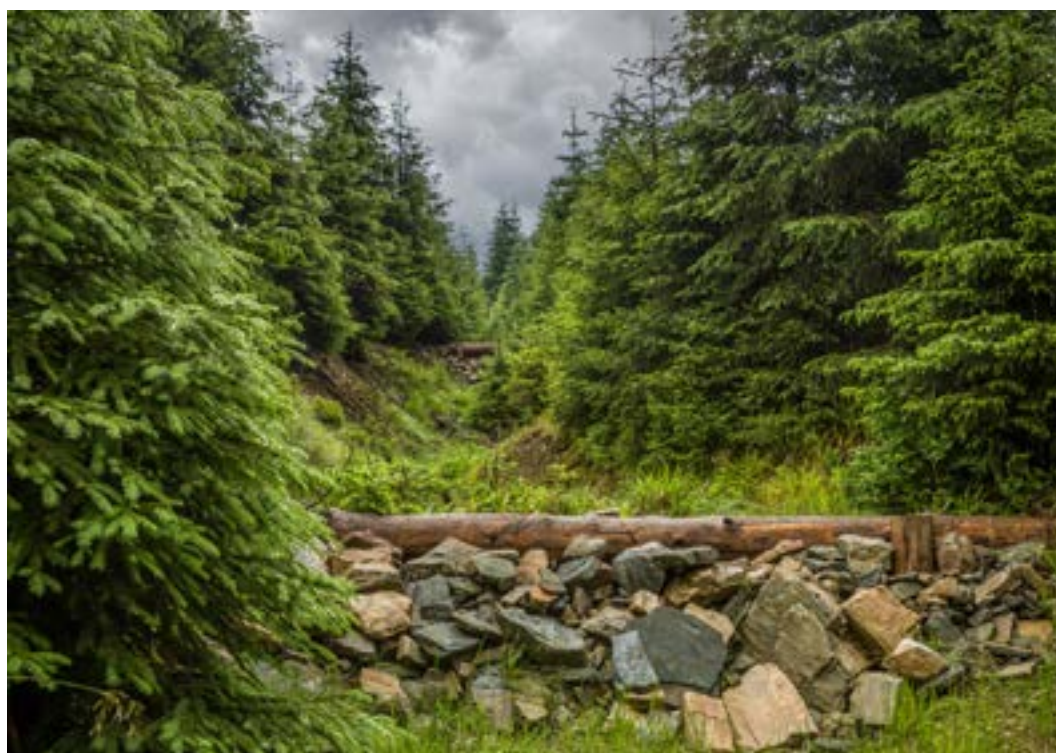
Fot. 8. Zabudowa przeciwozyjna w trasie spływów powierzchniowych, Nadleśnictwo Łądek-Zdrój (archiwum CKPŚ)
