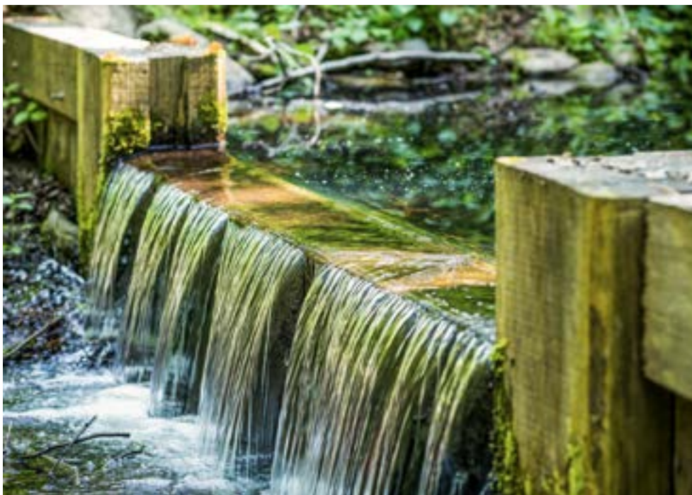
Fot. 128. Prog z obniżonym przelewem w Nadleśnictwie Solec Kujawski (fot. J. Smarczewski, 2023)
