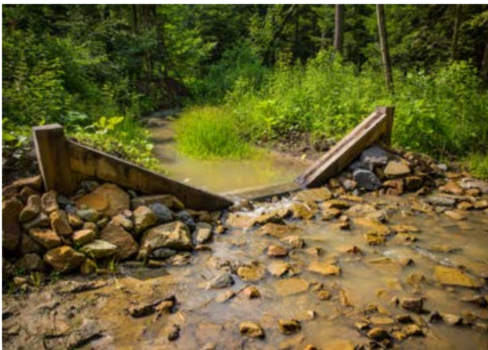
Fot. 37. Prawidłowo ubezpieczone stanowisko górne i dolne progu z pojedynczą ścianką szczelną, Nadleśnictwo Strzyżów (archiwum CKPŚ)
