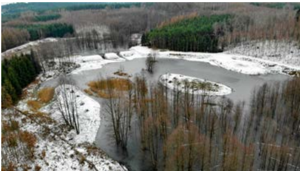
Fot. 9. Zbiornik z nieregularną linią brzegową, łagodnymi i ostrymi skarpami, przegłębieniami, wyspami z zacienieniem i nasłonecznieniem brzegów w Nadleśnictwie Trzebciny (archiwum CKPŚ)
