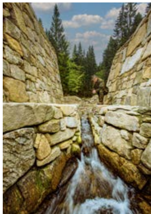
Fot. 138. V-kształtny przelew wody ze zbiornika przeciwpowodziowego w Nadleśnictwie Międzyzlesie, umożliwiający przejście rumowiska i samoczynne napełnianie i opróżnianie obiektu (archiwum CKPŚ)
