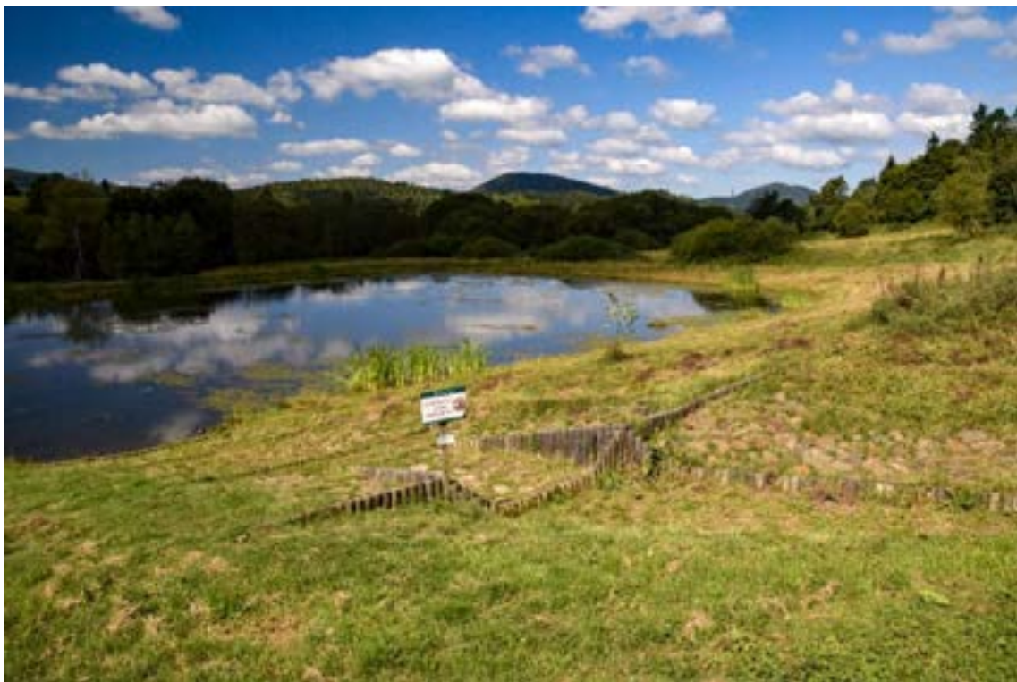
Fot. 119. Końcowy zbiornik w układzie kaskadowym w Nadleśnictwie Baligród zasilanym z cieku, a dodatkowo także wodą doprowadzoną z rowu przydrożnego – na pierwszym planie widoczne miejsce zasilania zbiornika wodą z rowu (fot. M. Mikulska)
