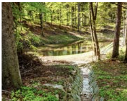
Fot. 14. Zbiornik zasilany spływami powierzchniowymi, w tym korytem kierującym wodę z wysoczyzny lub drogi w Nadleśnictwie Piwniczna, 2015 (archiwum CKPŚ)
