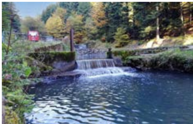
Fot. 89. Stopień wodny o konstrukcji betonowej (kaskada) w złym stanie technicznym, przerywający ciągłość biologiczną rzeki (fot. Ł. Borek)
