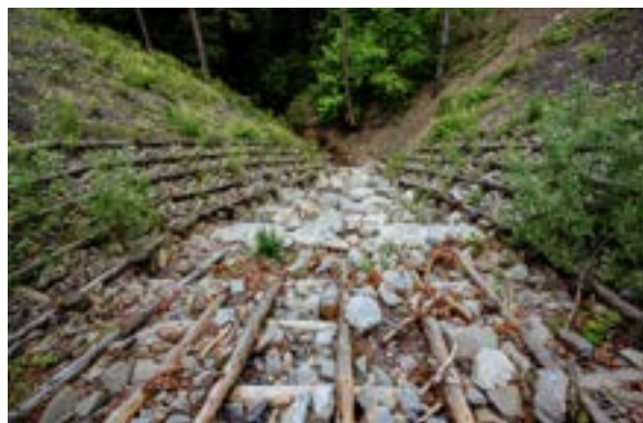
Fot. 79. Kratownica ożywiona wierzbą, 2015 (archiwum CKPŚ)
